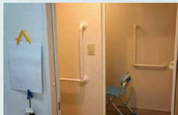
▼シャワールームを新設
